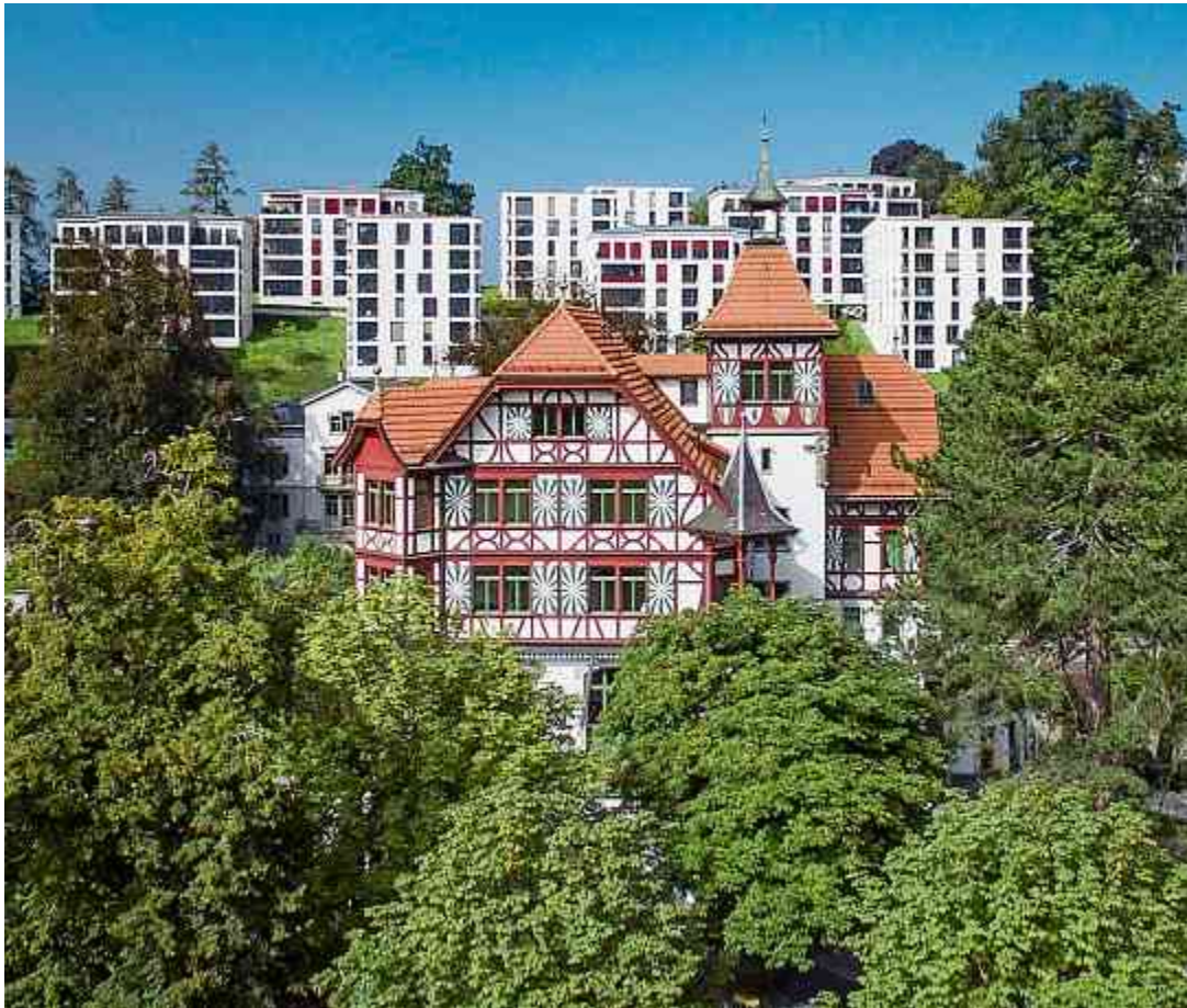
«Mit grosser Sorgfalt und Liebe zum Detail saniert»: Die «Militärkantine» auf dem ehemaligen St. Galler Kasernenareal.
